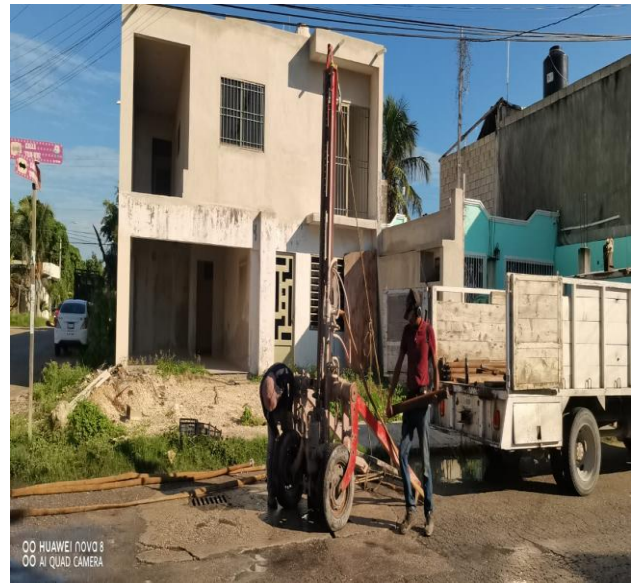
Desazolve de pozos. Calle tun-k'ul entre calle omega norte; colonia mayapax.
