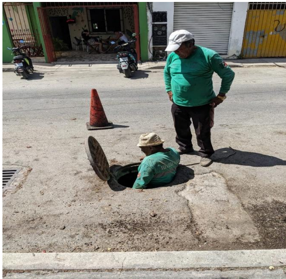
Limpieza de pozos. Calle 2 oriente entre calle osiris norte; colonia centro.
