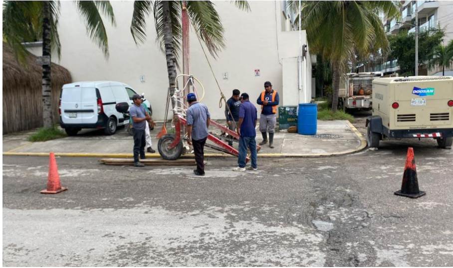
Desazolve de pozos. Calle escorpión sur entre av. Tulum y calle andrómeda; colonia centro.
