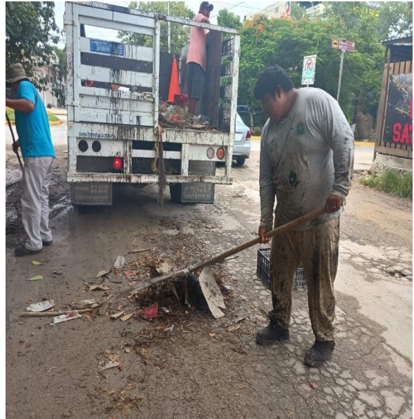
Limpieza de rejillas. Calle sagitario poniente entre av. satélite; colonia centro.
