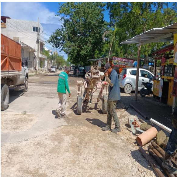
Desazolve de pozos. Calle mercurio poniente entre av. satélite sur; colonia centro.
