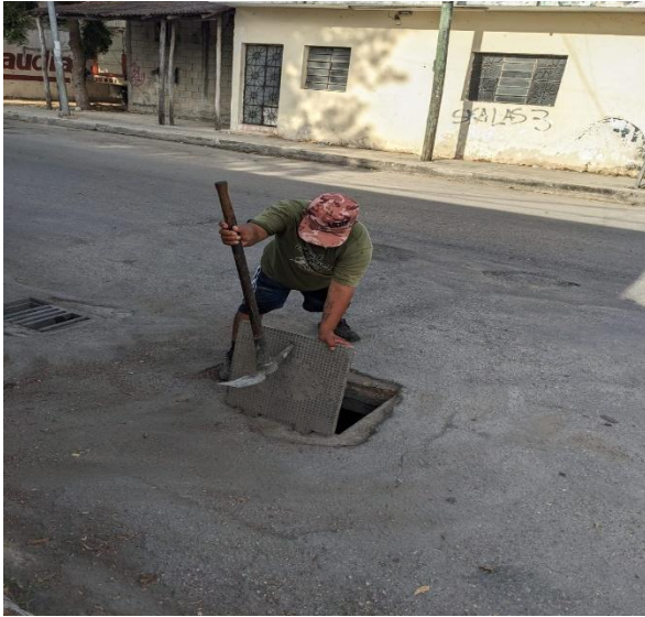
Limpieza de pozos. Calle alfa norte entre calle 2 poniente; colonia centro.
