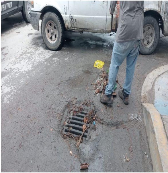
Limpieza de rejillas. Calle neptuno oriente entre calle centauro sur; colonia centro.
